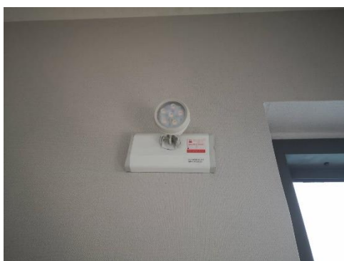
รูปภาพที่ 34 เครื่องสำรองไฟฟ้าฉุกเฉิน
