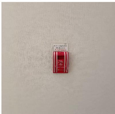
รูปภาพที่ 8 ปุ่มกดสัญญาณเตือนอัคคีภัย
